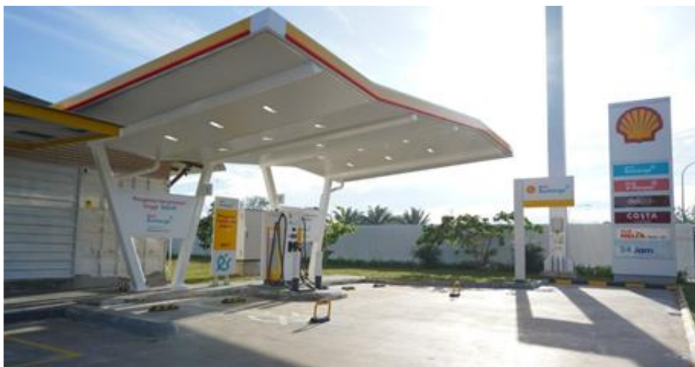
FOTO 4: Contoh Stesen Pengecasan EV di Stesen Minyak
