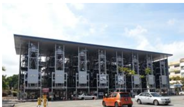
FOTO 2: Pemasangan TLK EV Tidak Dibenarkan Dalam TLK Mekanikal
